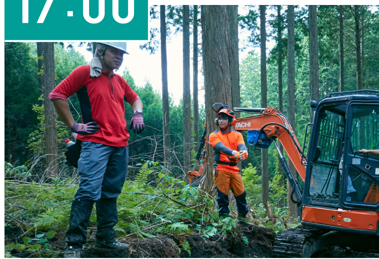
#現場作業終了 事務所にもどって簡単に業務内容をまとめます。
